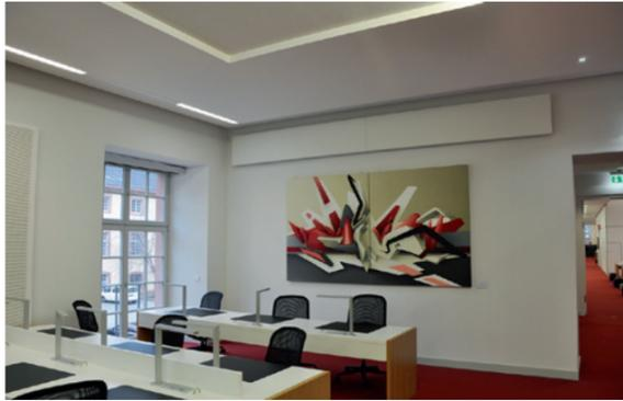
Die Abluft wird mit einer Öffnung mit freiem Querschnitt angesaugt. Die Öffnung ist verblendet und geschickt in das Raumkonzept eingebunden. Beispielsweise dient diese Verblendung als Aufhängeprofil für ein Gemälde.
