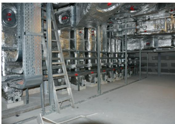
Die zentral aufbereitete Zuluft wird in der Technikzentrale in Einzelstränge aufgeteilt. Die komplette Verteilung und Regelung mit Zonenheizern und motorbetätigten Regelklappen erfolgt in der Technikzentrale. Eine Unterverteilung in den Geschossen wird nicht benötigt.
