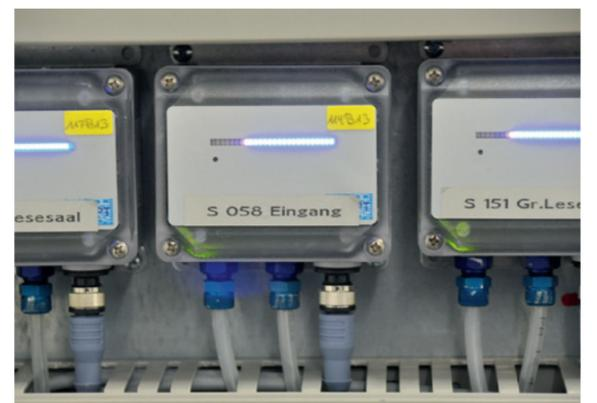
Jeder Drucktransmitter ist einem Raum im Gebäude zugeordnet und mit Schläuchen verbunden. Statt die Transmitter dezentral in den Räumen zu verteilen und über Kabel mit der Steuerzentrale im Dachgeschoss zu verbinden, kann so die Funktion aller Sensoren übersichtlich an einem Ort überprüft werden.
