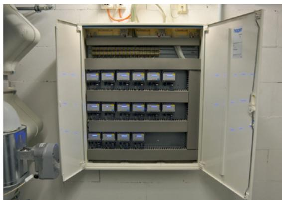
Eine ungewöhnliche Installation. In diesem Schaltschrankgehäuse befinden sich ausschließlich die Drucktransmitter, die die Differenzdrücke in den be- und entlüfteten Räumen aufnehmen. Der Schaltschrank ist das Herzstück des Systems, da das Lüftungskonzept auf dem Differenzdruck in den Räumen aufbaut.
