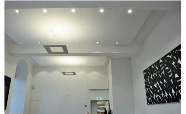
Selbst in hohen Räumen funktioniert das Lüftungskonzept. Die Luft strömt seitlich aus dem Deckenplenum und verteilt sich gleichmäßig im Raum. Die Abluft wird über eine einzige verblendete Öffnung über der Tür abgesaugt. Die Anordnung deckt sowohl den Heiz- als auch den Kühlfall ab.
