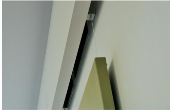
Die Abluftöffnung hinter der Verblendung ist schwer zu erkennen. Klassische Lüftungsdurchlässe werden nicht mehr benötigt.
